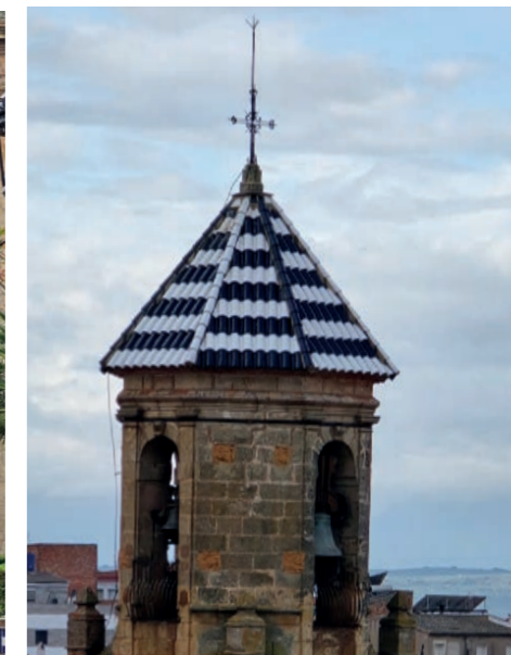
Torre del campanario de la iglesia.
